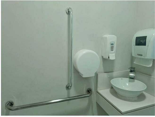
Figura 5. Bancada de pia com espaço inferior livre para melhor acessibilidade.
