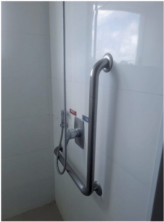
Figura 6. Área de banho com barra de apoio e acionador de chuveiro com monocomando.
